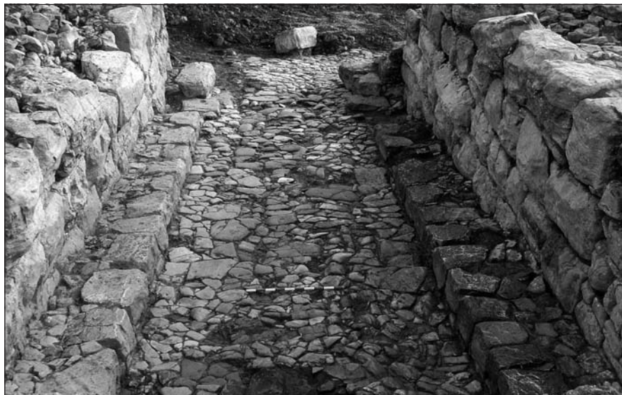
Detalle de la puerta oriental flanqueada por las dos torres.
