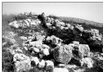
Estado actual de la vivienda.
